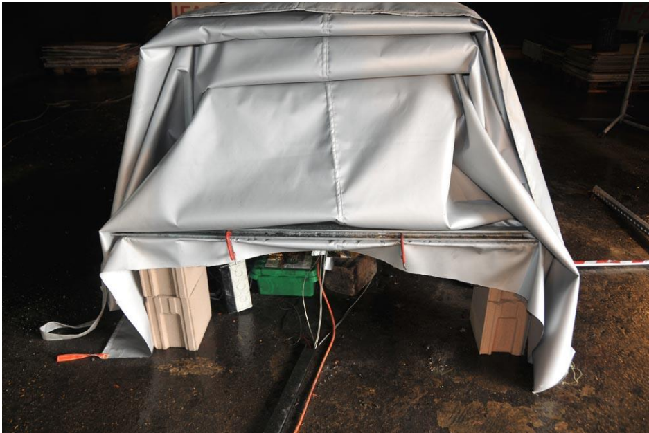
Bild 11: Befestigung der Brandbegrenzungsdecke
