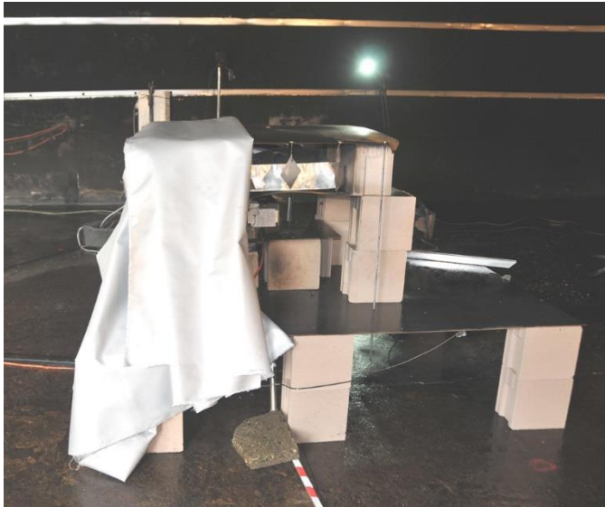
Bild 12: Vorbereitung der Brandbegrenzungsdecke
