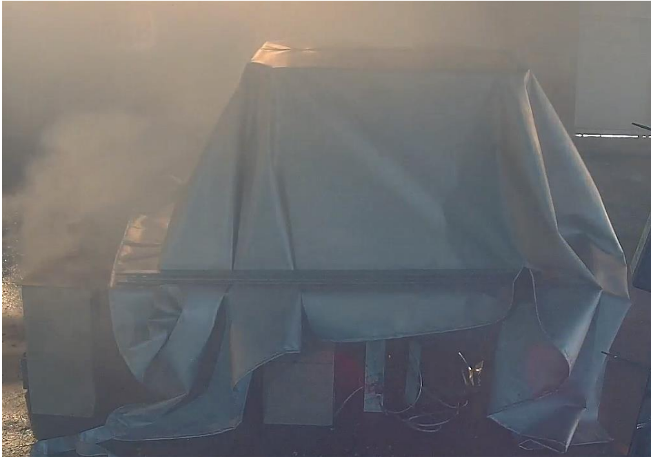
Bild 19: Sicherung der Decke durch beidseitiges Auflegen von Schienen
